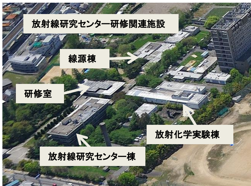
図1. 大阪府立大学放射線研究センターにおける放射線関連研修施設配置 線源棟：加速器・密封放射線照射施設 放射化学実験棟：非密封放射性同位元素取扱施設
